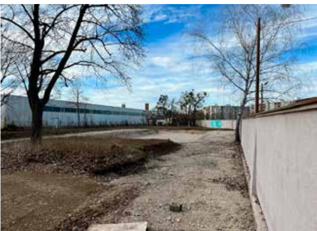
Blick auf das Grundstück Westendstr. 210 nach Entfernung des Gebäudes
