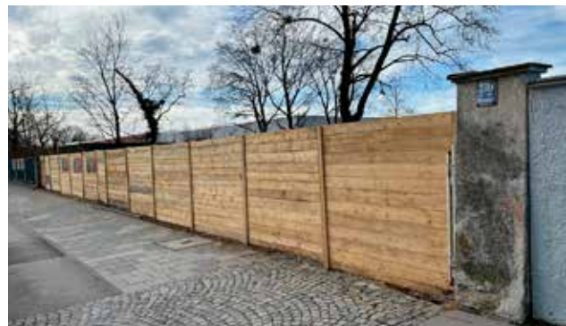
Das Grundstück Westendstr. 210 zum Gehweg abgesichert
