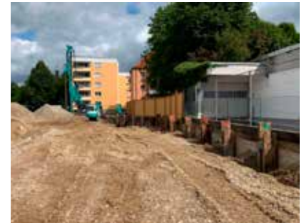
Aushub und Beginn der Bauphase
