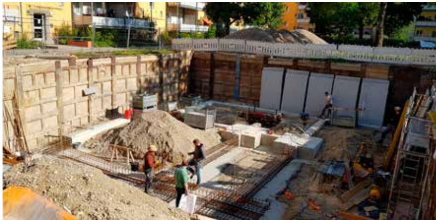
Erweiterung der Tiefgarage
