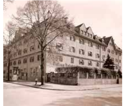
Wohnanlage Altöttinger Straße – Schlüsselbergstraße, Gaststätte „Verkehrsverein“
