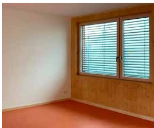
Holzbauweise der Kita, innen
